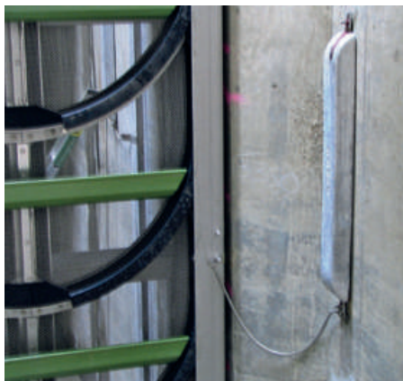
Abb. 6: Schutz einer Geiger MultiDisc® Sieb- reinigungsmaschine mit Hilfe von Opfer- anoden
