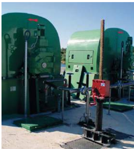
Geiger® und Passavant® Siebband – von außen nach innen durchströmt
