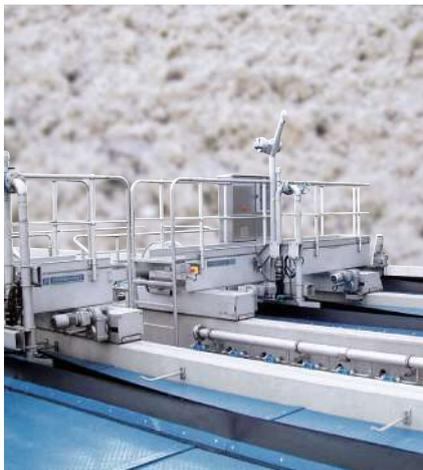
Automatische Austragung von sedimentierten Stoffen am Boden, sowie von leichten Stoffen an der Wasseroberfläche, die durch die Trennung von Schwer- und Leichtstoffen in Sandfängen der mechanischen Abwasserreinigung anfallen. Dadurch werden Ablagerungen sowie technische Probleme der nachfolgenden Einrichtungen verhindert.
