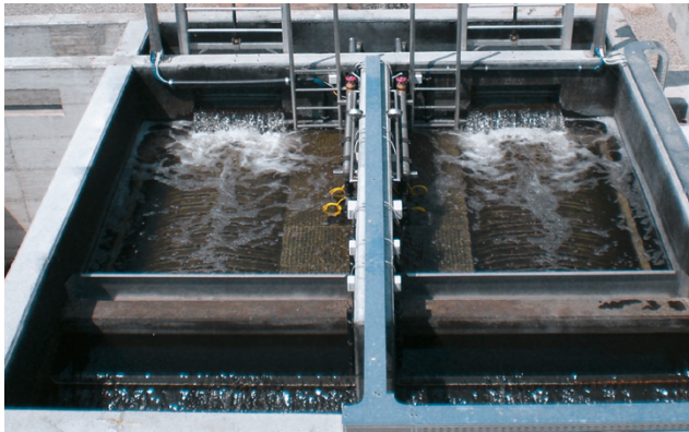
Passavant® Tuchfilter hinter einer konventionellen Nachklärung
