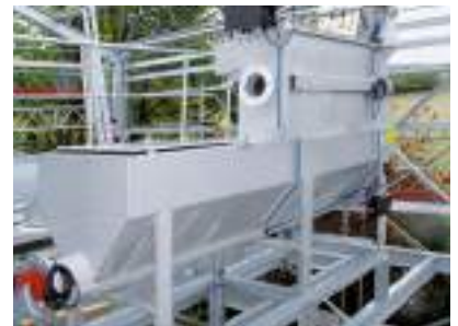
Installation einer ECO-Combi 50
