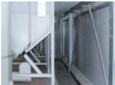
Plattform zwischen Combi und Wand
