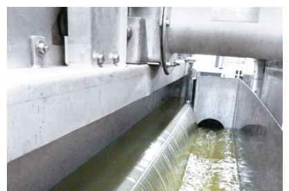
Ablauf des gesiebten Abwassers
