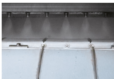
Siebreinigung mit Luft-/Wasserspülung
