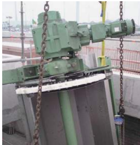
Installation der Antriebswelle eines Geiger® Siebbandes
