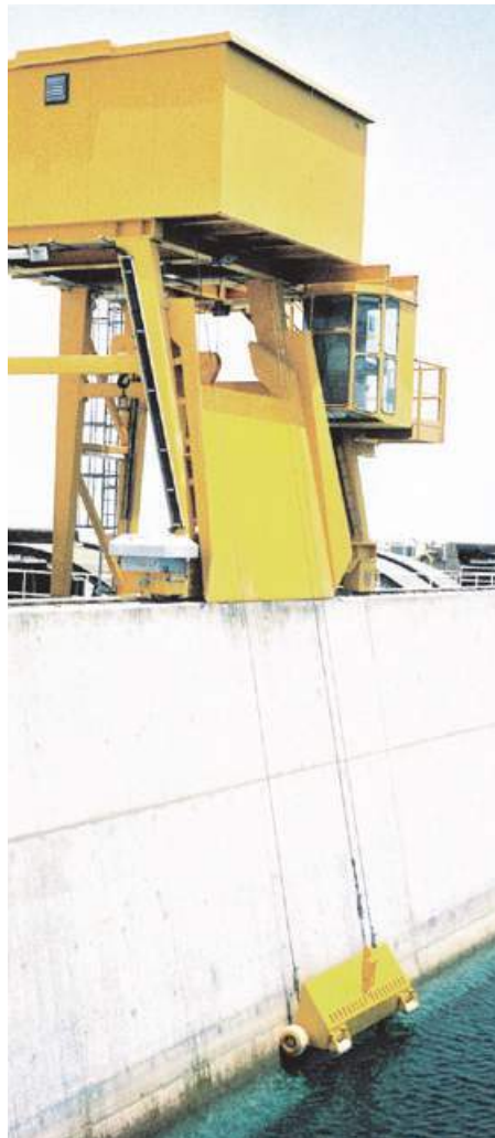
Bild unten rechts: Passavant®/Geiger® Verfahrbarer- Schalengreifer- rechen im Betrieb in einer schwedischen Anlage
