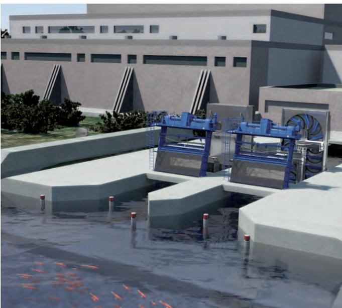
Prise d'eau à deux canaux avec système de répulsion des poissons Geiger® et système automatique de renvoie des poissons Geiger®
