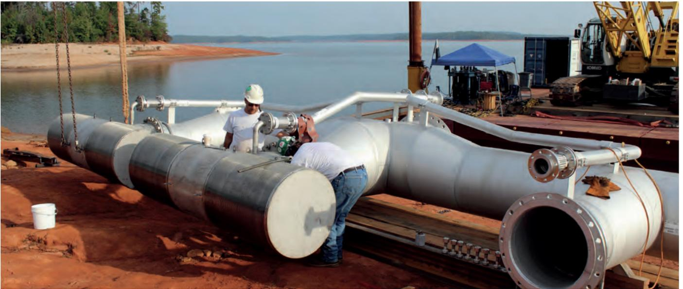
Instalación de filtros pasivos Johnson Screens®: Planta de agua potable en South Carolina, EEUU
