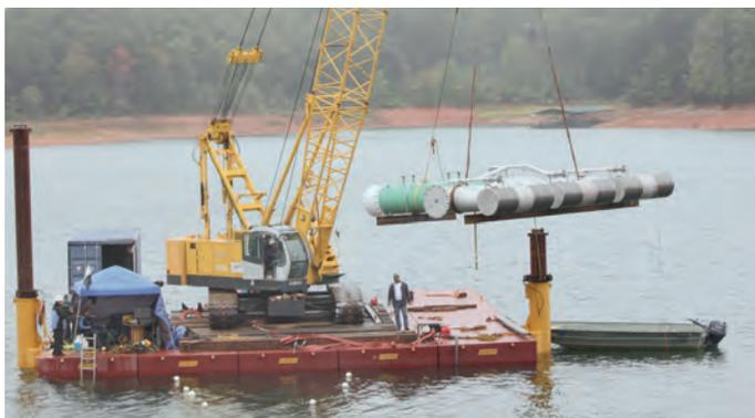
Instalación de Sistema Offshore Johnson (Johnson Offshore Intake Systems™ – JOIS™)
