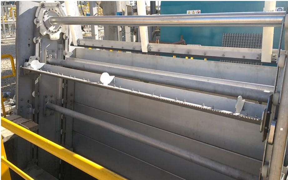
Geiger® Kettenumlaufrechen während der Inbetriebnahme
