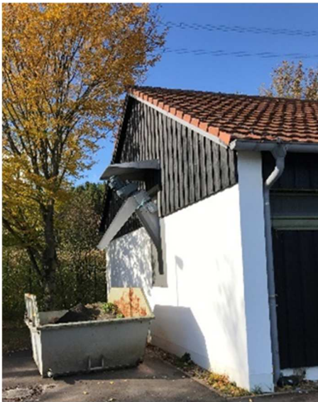
Außenansicht des Rechengebäudes (Sandaustragsförderer mit Wand- durchführung)
