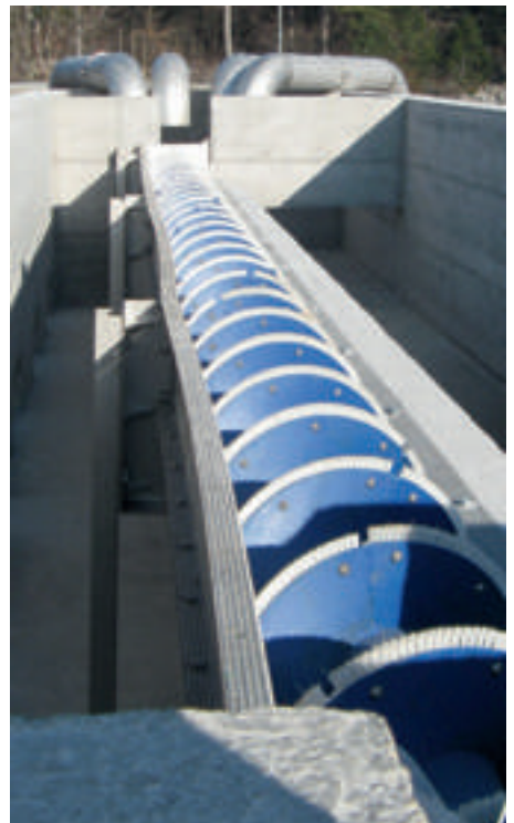
Noggerath® Überlaufsieb OVF für Regenüberlaufbecken
