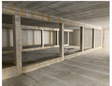
Regenrückhaltebecken
