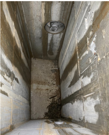
Feststoff-Sammelschacht
