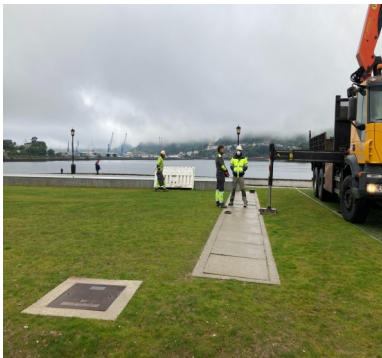
Regenrückhalte-Park als Grünfläche in die Landschaft integriert
