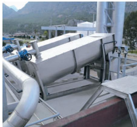
Pressa a vite per fanghi Passavant® modello PSP
